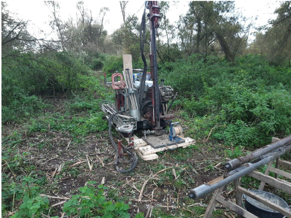
Abbildung 1: Bohrgerät auf dem Bohrplatz der Kleinrammbohrung K 1 (Aufnahme vom 27.10.2025)
