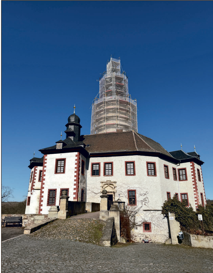
Der Burgfried, der zentrale Turm der Burg Posterstein, wird saniert.
