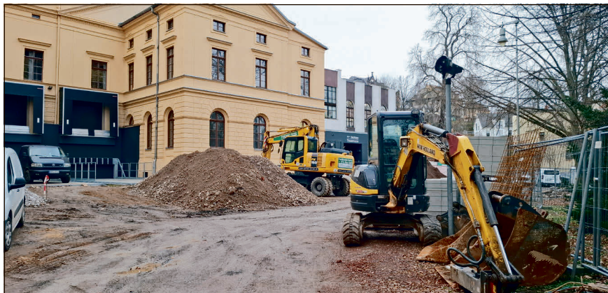
Mit Hochdruck wird an den Außenanlagen gearbeitet.
