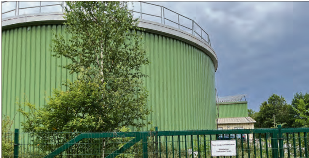
Ende 2009 wurde die Biogasanlage in Betrieb genommen.
