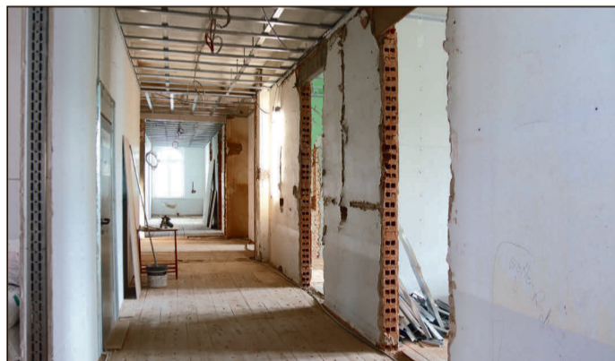
65 Büroarbeitsplätze, Beratungs- und Technikräume entstehen.
