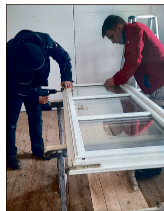
155 Holzfenster werden nach und nach saniert.
