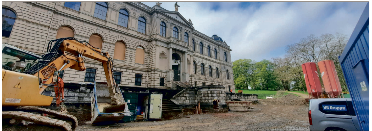
Das Lindenau-Museum ist eine Großbaustelle.
